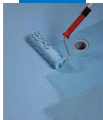
Нанесение валиком второго слоя Mapelastic AquaDefense
