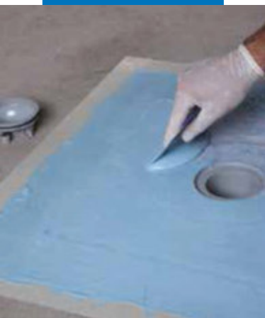
Пропитка ткани Drain Vertical составом Mapelastic AquaDefense
