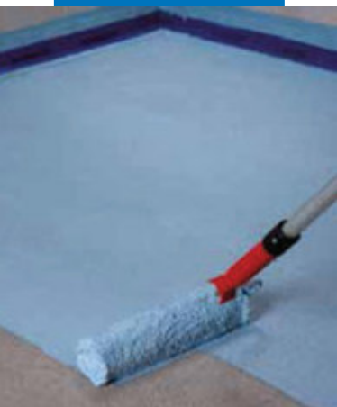
Нанесение первого слоя Mapelastic AquaDefense на стяжку
