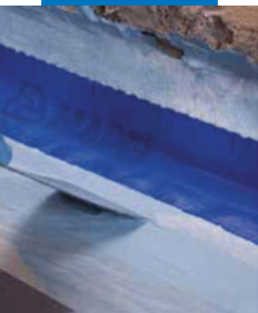
Укладка Mapiband на стык между полом и стеной с помощью Mapelastic AquaDefense
