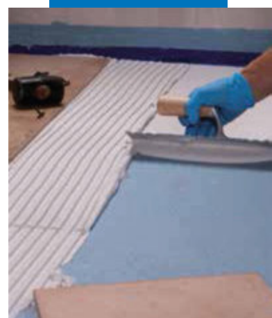
Приклеивание плитки на Mapelastic AquaDefense
